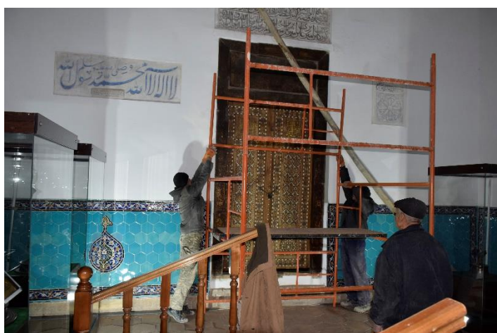
Рисунок 9. Процесс демонтажа металлического обрамления двери.
